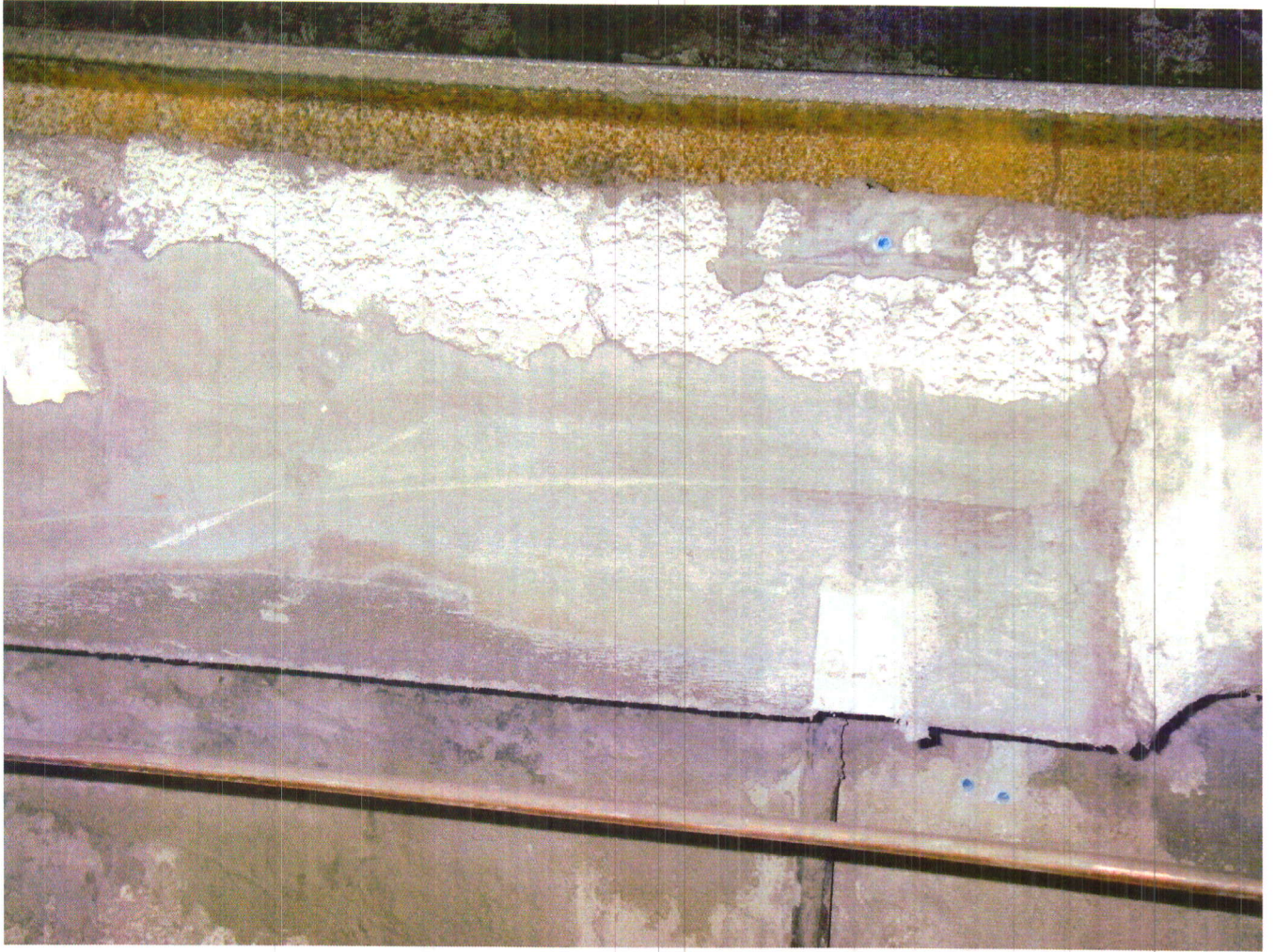
Рис. 2. Вид отремонтированной части балки после 2-х месяцев эксплуатации после ремонта.
